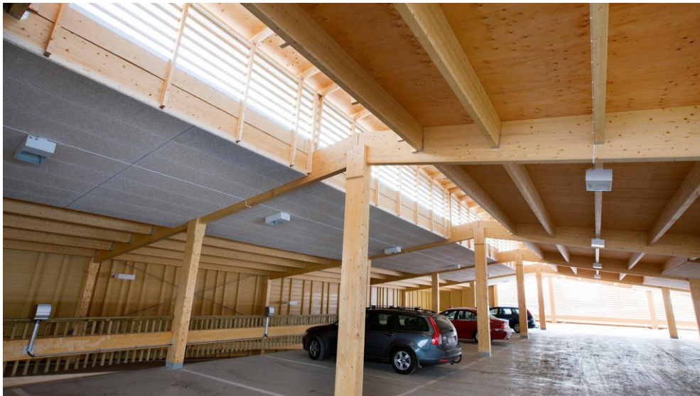
Figur 2 Parkeringshus i trä i Skellefteå, för boende i kvarteret Ekorren (33 bostadsrättslägenheter) samt för fastighetsbolaget Polaris. Totalt 81 platser. Två plan i betong under jord och fyra plan i trä ovan jord, varav ett i gatuplan för butik och kontor. Stomme, bjälklag, ytterväggar och hisschakt av limträbalkar och korslaminerat trä.
