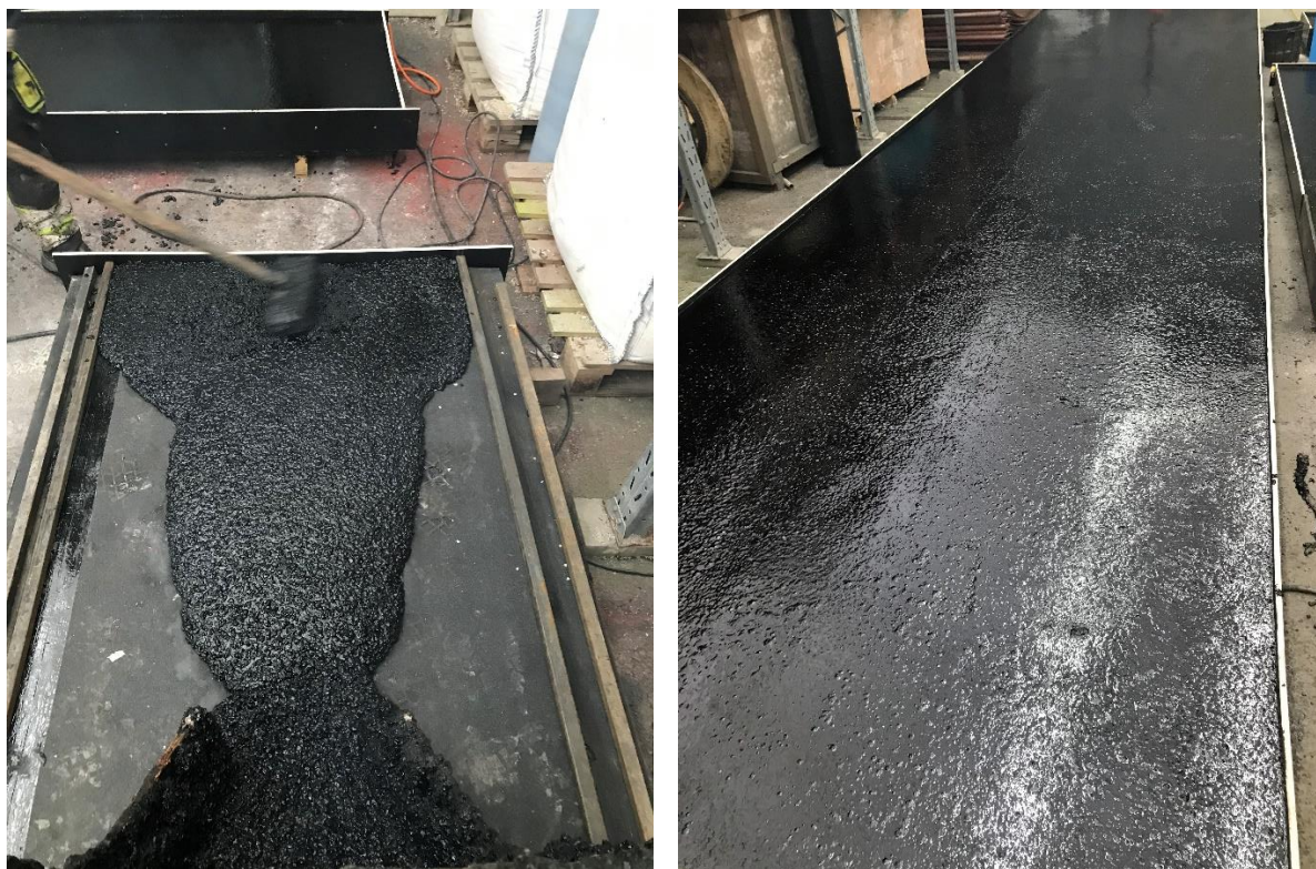
Figur 4 Första lagret gjutasfalt läggs ut
