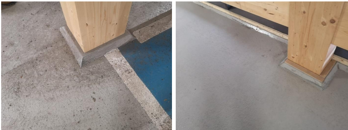
Figur 10 Exempel på pelare i parkeringshus av trä
