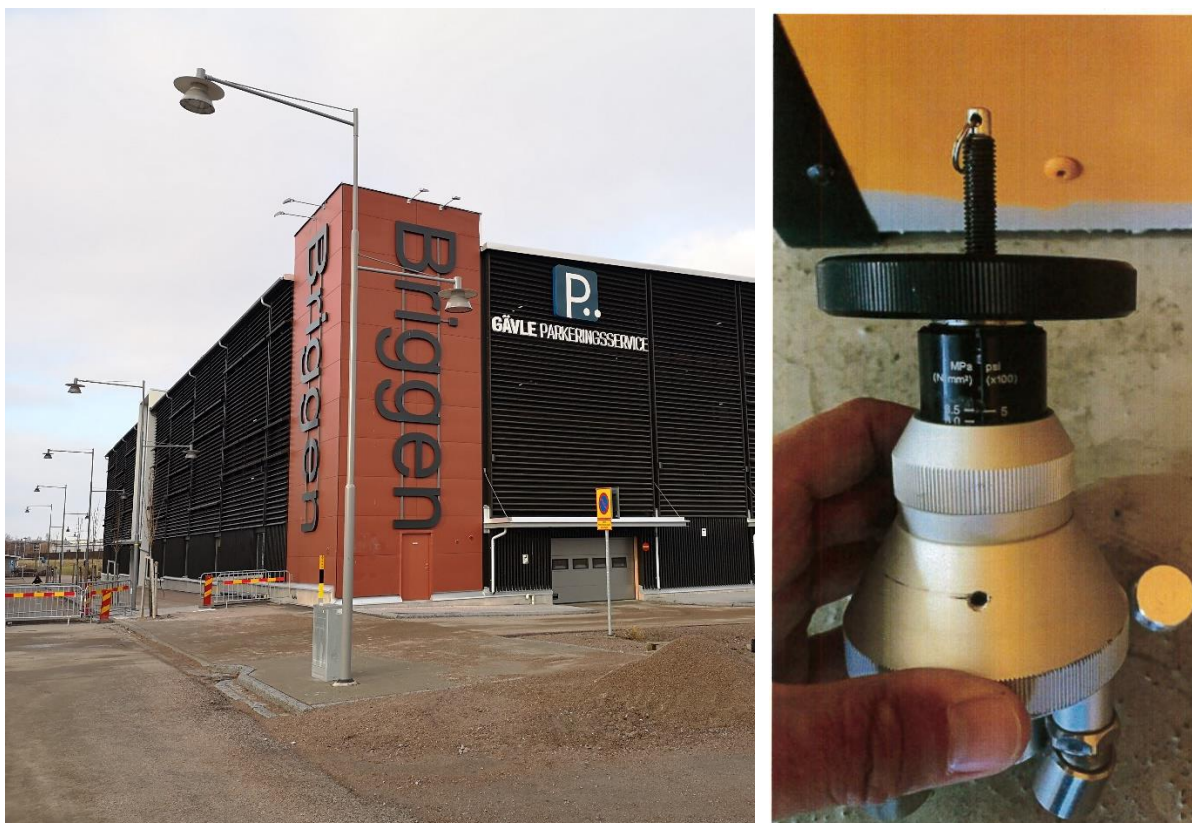
Figur 6 Parkeringsgarage Briggen i Gävle, med exempel på genomförd provdragning (med limbrott)
